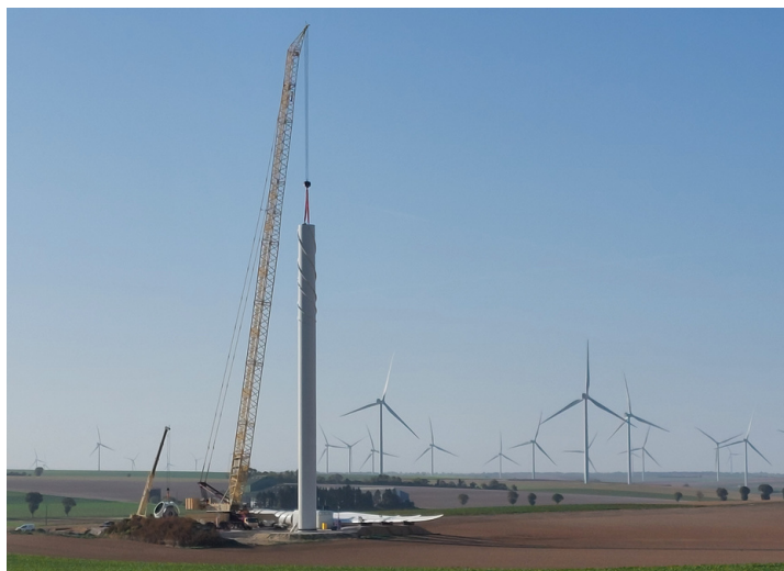
Levage des tronçons de mât des éoliennes
