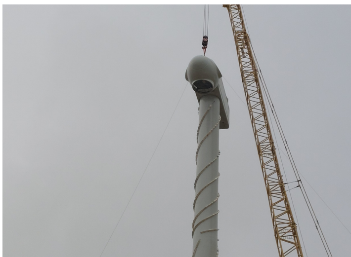
Levage des nacelles et moyeux des éoliennes
