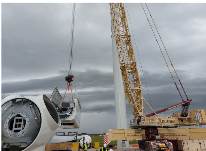
Levage des nacelles et moyeux des éoliennes
