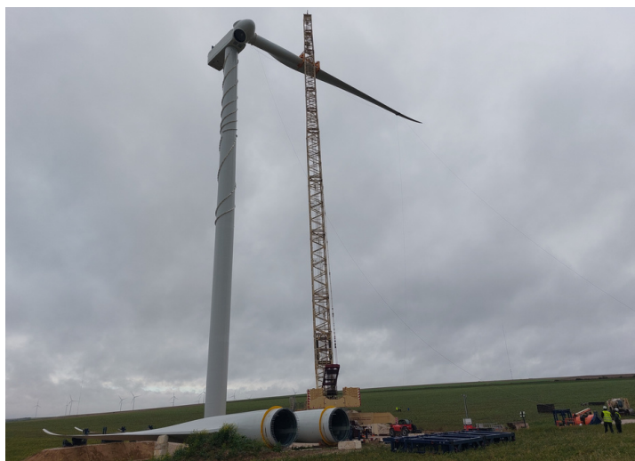
Levage des pales des éoliennes
